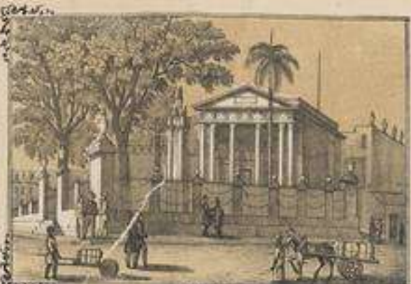
TEMPLE Edificio en memoria de la reina que se dijo en la Ciudad.
