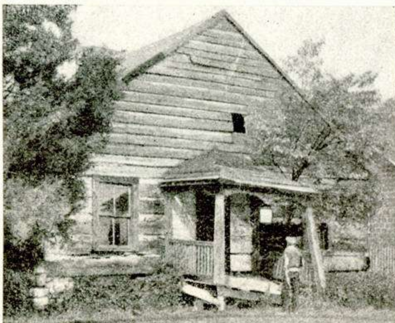
Fig. 58. — Casa construída con madera. Fot. Nacional Geographic Magazine.
