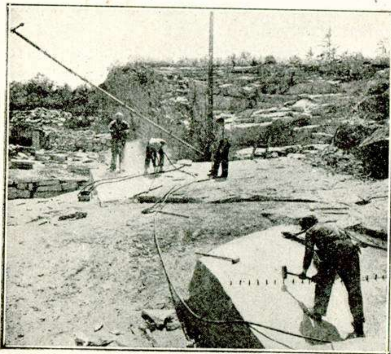
Fig. 45.—Cantera de granito, el obrero del primer término utiliza cuñas para cortar grandes bloques de piedras, mientras que los de segundo término emplean perforadoras. — Fot. Higgins Mose.
