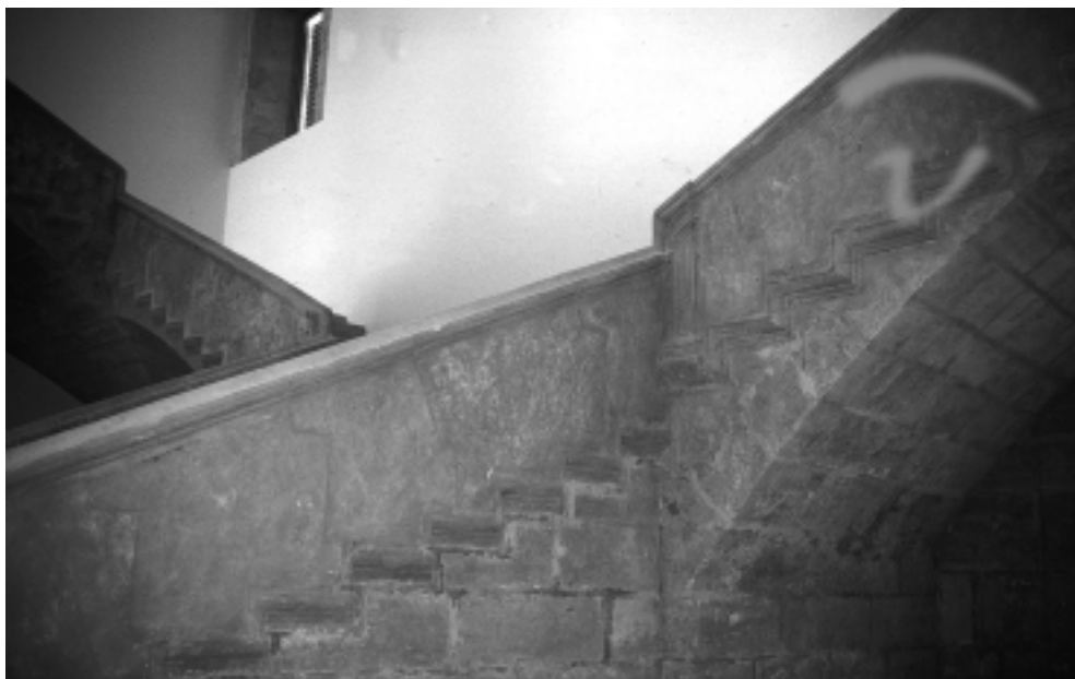
Escalera principal, lado oeste del claustro sur
