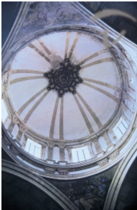
Interior de la cúpula antes de su restauración
