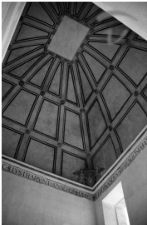
Bóveda de la escalera del paso entre claustros
