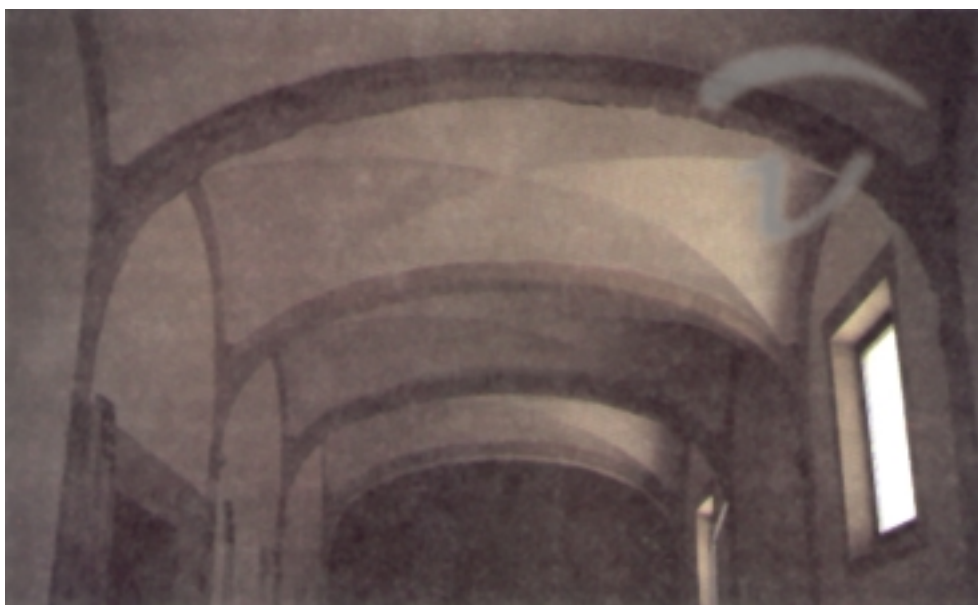
Vista de la panda meridional del claustro sur, después de los trabajos de restauración
