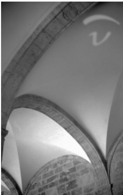
Arcos fajones de la esquina sudeste de la planta baja del claustro sur
