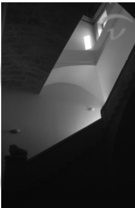
Escalera y sobrescalera del paso entre claustros
