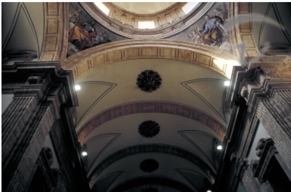
Bóveda de cañón con lunetos de la nave de la iglesia
