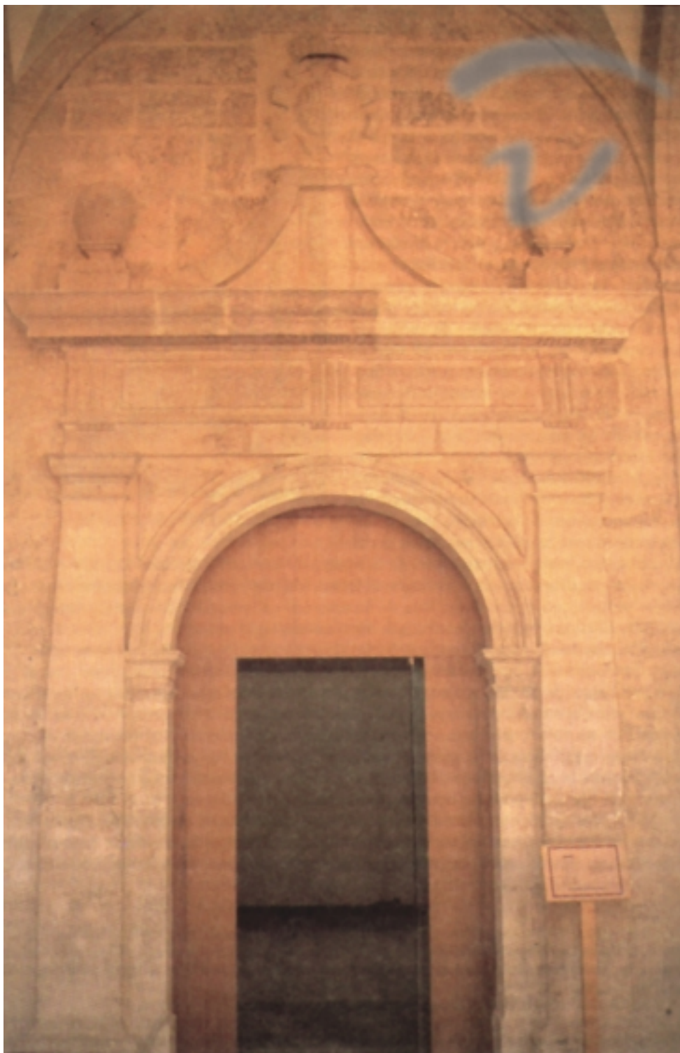
Portada de acceso al zaguán de la librería, en el lado meridional del claustro sur
