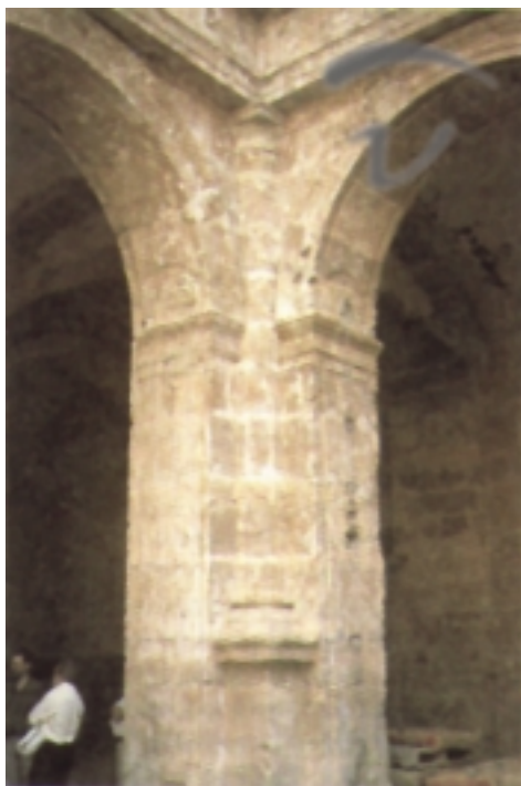
Planta baja del claustro sur, esquina nordeste. Antes de la restauración
