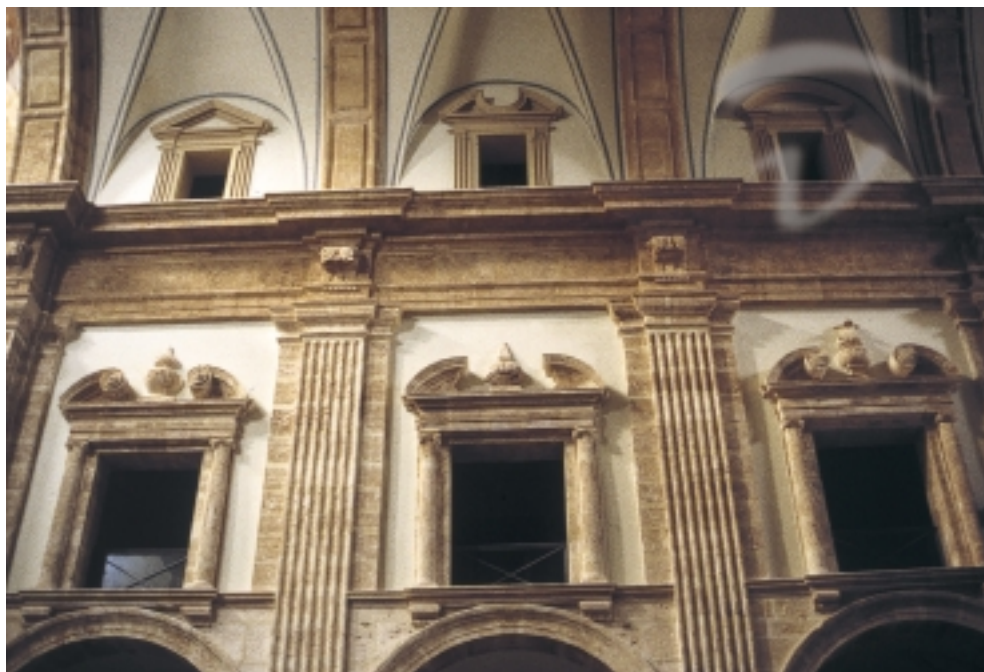
Vista de las primeras tribunas de la iglesia, lado del Evangelio
