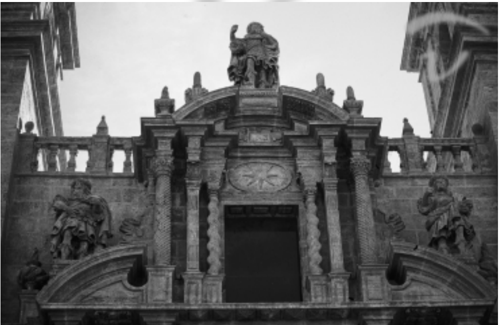
Ático de la fachada de la iglesia con los Reyes Magos y la estrella que los guió
