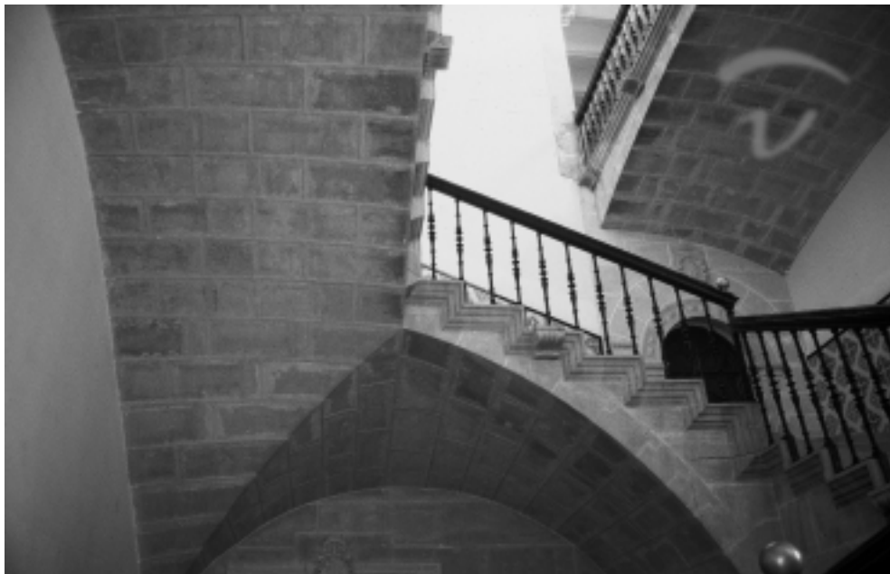
Escalera del colegio de Santo Domingo, Orihuela
