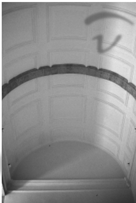
Bóveda de la escalera principal
