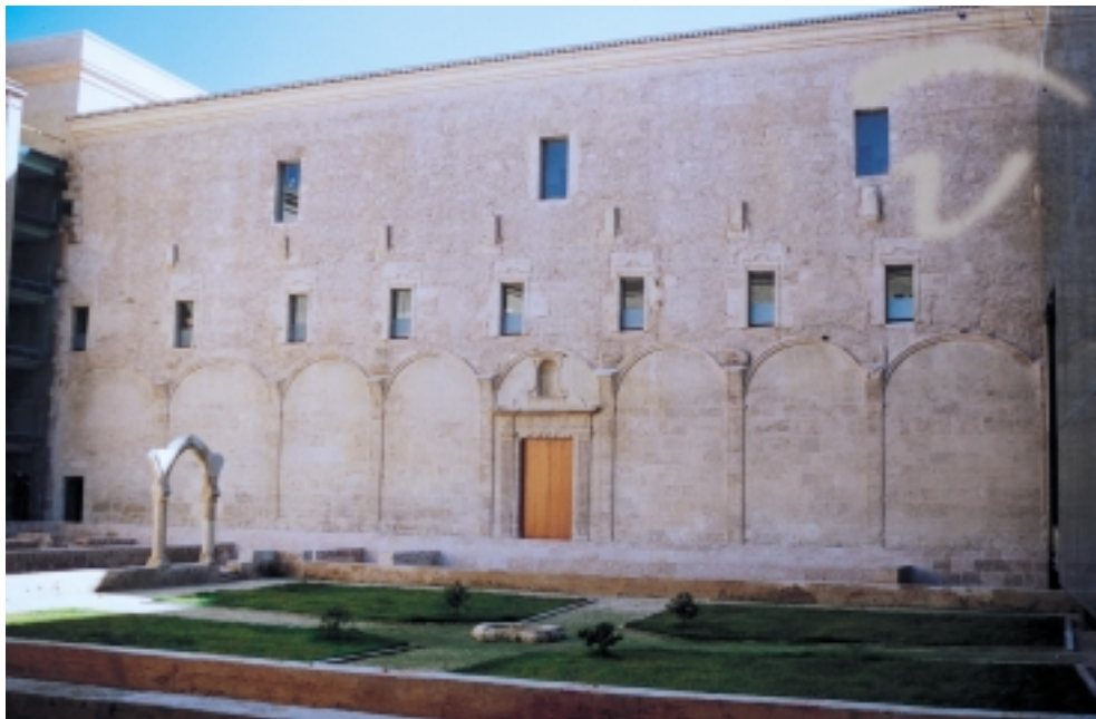
Obra iniciada en el lado este del proyectado claustro norte
