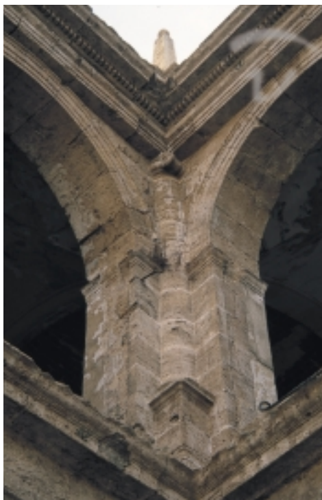
Primer piso del claustro sur, esquina nordeste. Antes de la restauración
