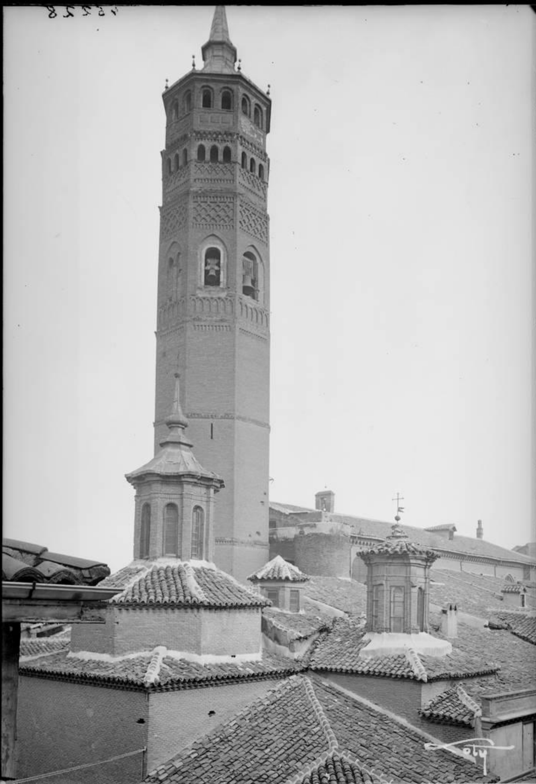
Zaragoza 46228 - Torre de la Iglesia de San Pablo
